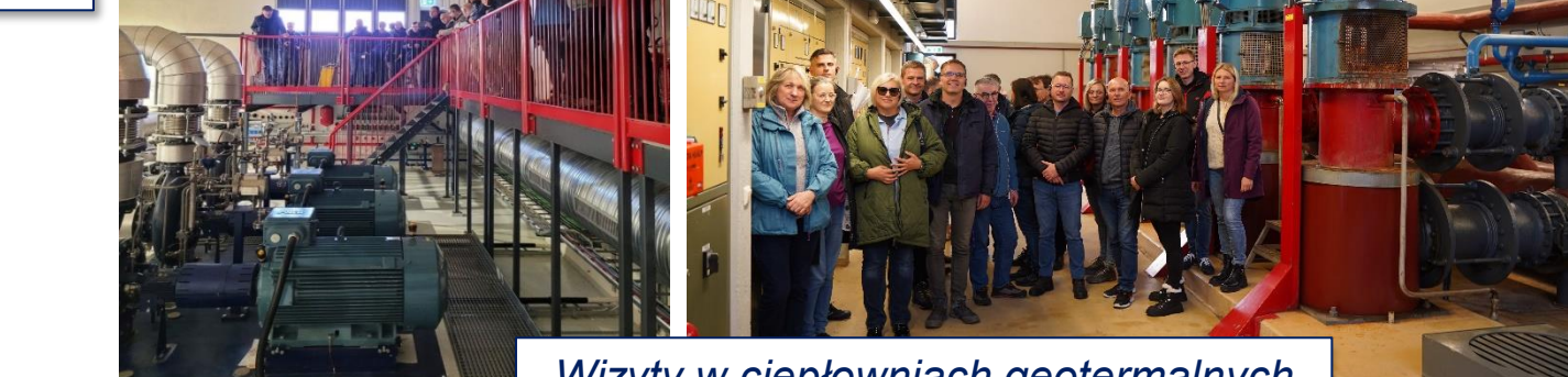
Wizyty w ciepłowniach geotermalnych
