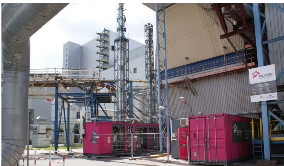
Rys. 2. Rozruch Instalacji Pilotowej w Elektrowni Jaworzno – 2014
