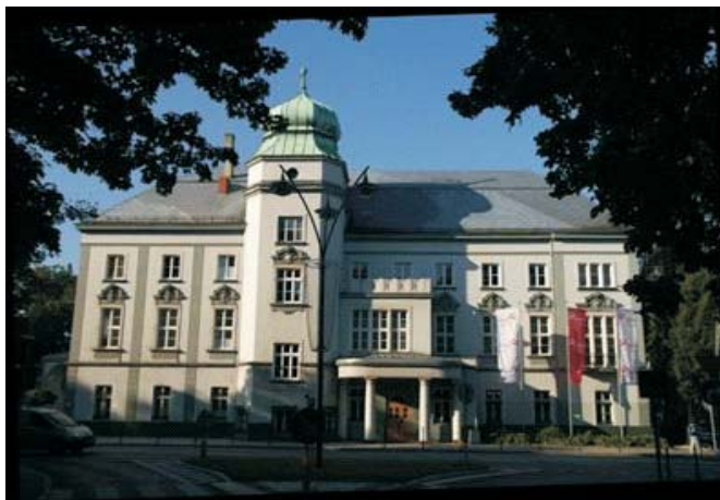
Fot. 1. Siedziba Południowego Koncernu Węglowego S.A. w Jaworznie (źródło własne)
