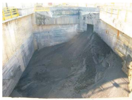
Fot. 14. Zbiornik na zawiesinę wodno-mułową (źródło własne)
