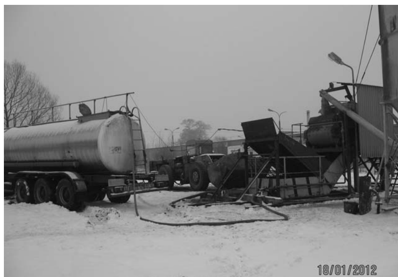
Fot. 3. Zbiornik solanki (cysterna) oraz ładowarka łyżkowa w czasie pracy
