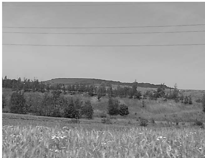
Rys. 4. Budowla KWK „Pniówek”
