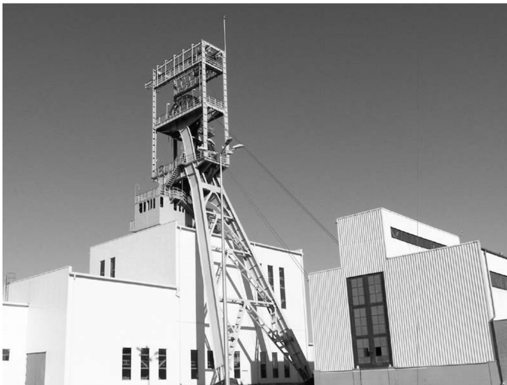
Fot. 5. Wieża szybu 2.2 z budynkiem maszyny wyciągowej w Stefanowie
