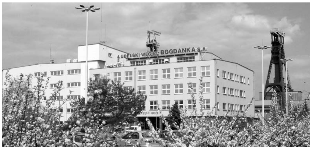
Fot. 1. Cechownia i budynek kompleksu BHP w polu głównym w Bogdance
