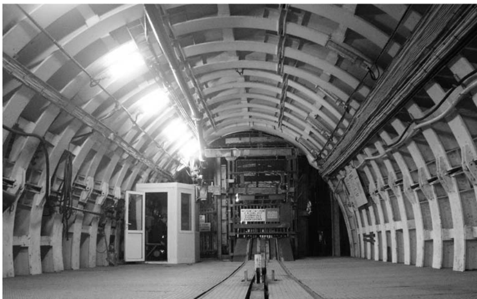
Fot. 3. Podszybie szybu 2.2 na poziomie 990 m w Stefanowie
