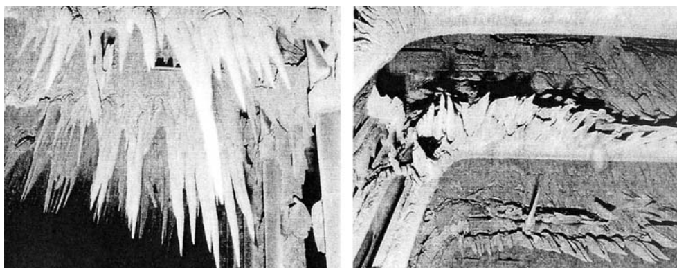
Rys. 8. Nawisy na węzownikach przegrzewaczy pary wtórnej kotła fluidalnego
