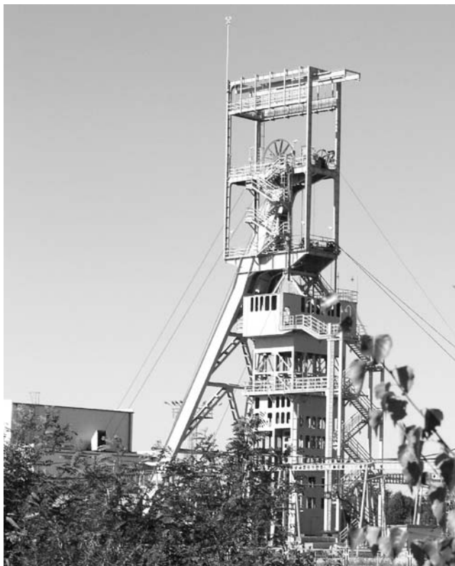
Rys. 1. Widok wieży szybowej szybu 2.2 w Stefanowie
